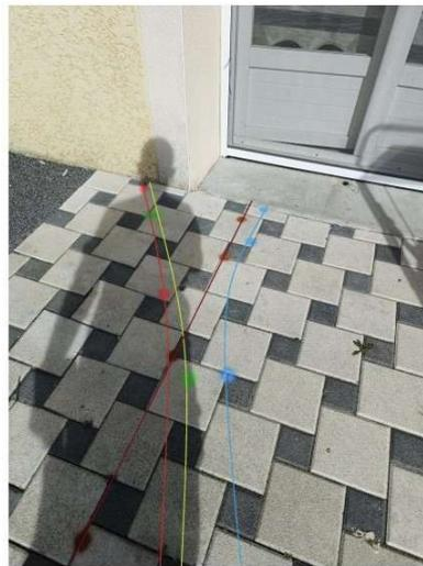
Devant la porte fenêtre, pénétrations des réseaux électrique en rouge, télécom en vert et AEP en bleu. Sortie d'un réseau EU en brun.
